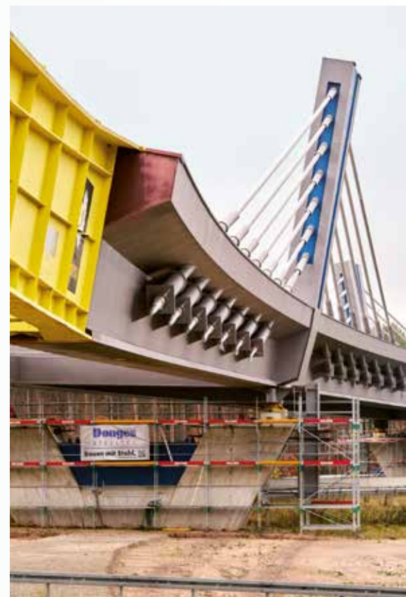
Für den Overfly am Autobahnkreuz Nürnberg-Ost kamen unter anderem 1 700 Tonnen Bewehrungsstahl und 8 500 Tonnen Stahlverbundüberbau zum Einsatz.
