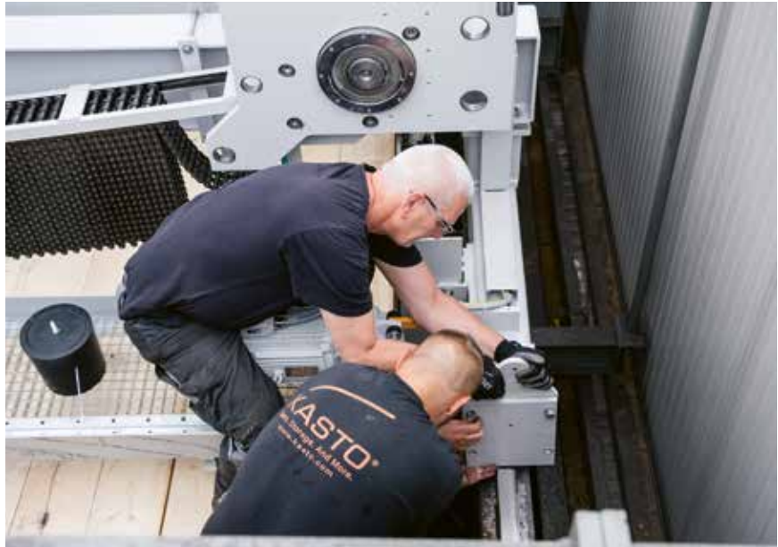
Das neue Regalbediengerät – Herzstück des Retrofits – wurde durch das Hallendach eingelassen.
